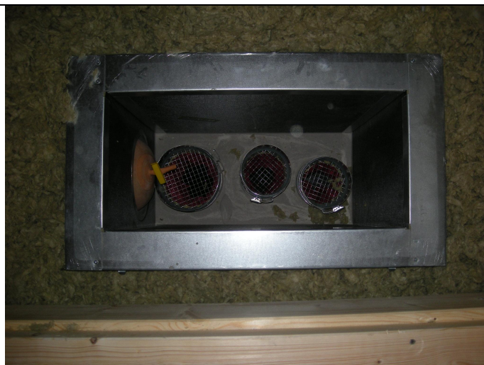
Bild 6. Kanaler tätas på vinden, i samlingslådor.
