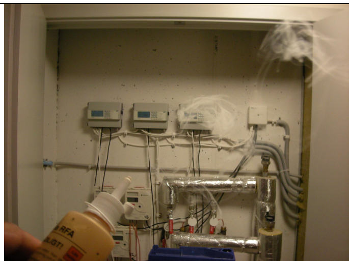
Bild 11. Läcksökning vid elinstallationer.
