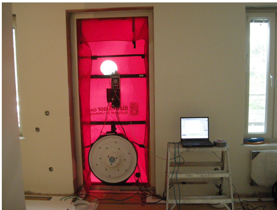
Bild på monterad Blower Door vid täthetsprovning av en enskild lägenhet.
