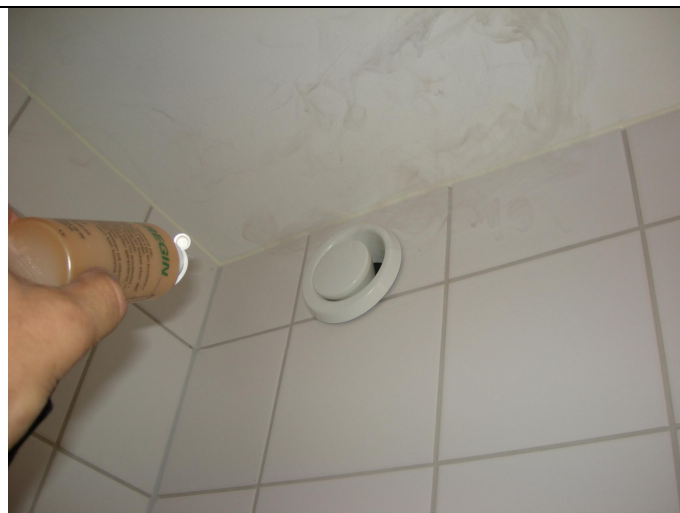
Bild 9. Kontroll av don för att se att kanaltätningar på vinden är täta.
