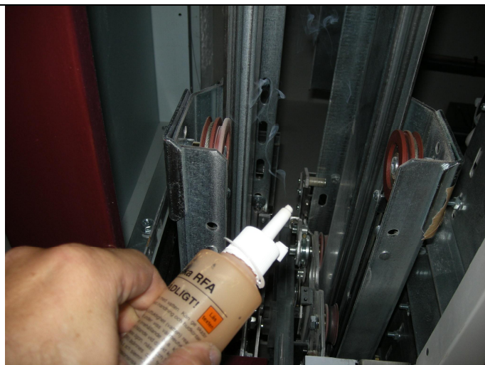
Bild 10. Läcksökning vid hiss-schakt.
