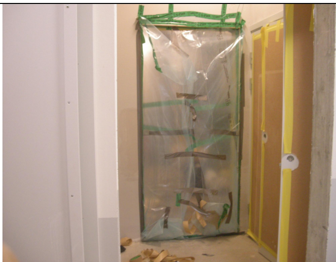
Bild 3. En provisorisk dörr konstrueras i dörrhålet till garaget. Plast och träreglar.
