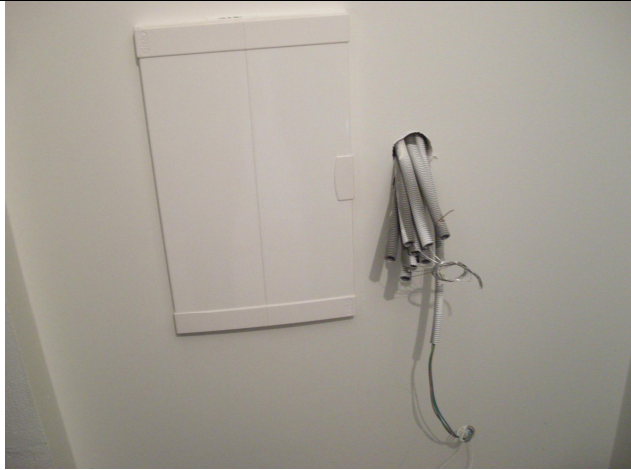
En vanlig källa till luftläckage. Kabelrör för data.
