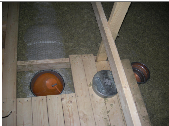
Bild 7. Kanaler tätas på vinden.
