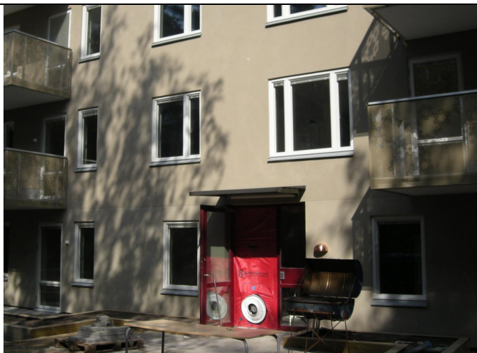
Bild 1. Blower Door placeras i entrépartiets dörröppning.
